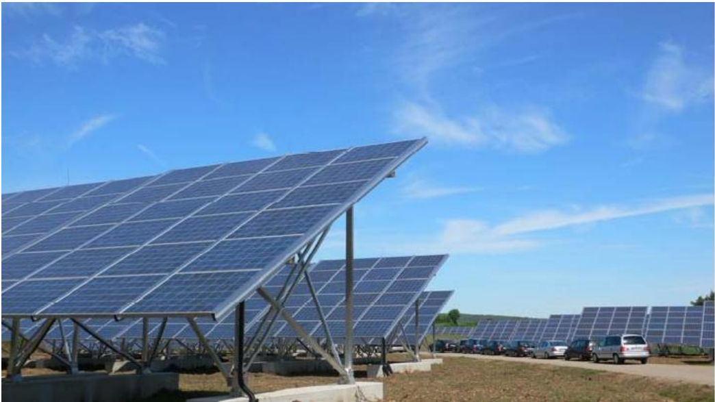
图2-1 固定式安装方式
